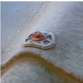
Fijar la placa Olandese Isolife a la estructura de soporte con no menos de 9 tornillos. Se aconseja utilizar para la fijación de las placas los tornillos autoroscantes de 130 mm (artículo VTL6130 para madera y VTA6130 para metal)
