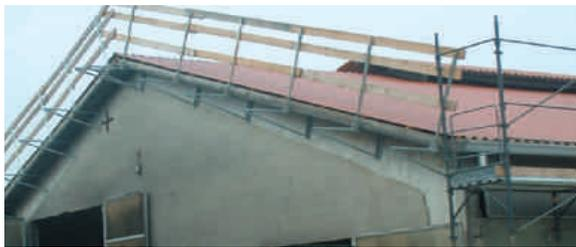
El perímetro exterior de la cubierta debe ser protegido por el andamio o un parapeto; para mayor seguridad en las áreas de la obra, la entrada debe ser reservada solo a los trabajadores de la obra.
