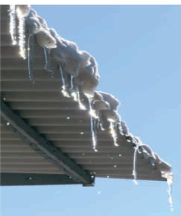
La superficie de las placas **COVER-LIFE** de material acrílico permite, en presencia de nieve o hielo, una excelente resistencia a la abrasión debida al deslizamiento, resistiendo además a los choques térmicos, incluso a temperaturas muy bajas (-20 ° C).
