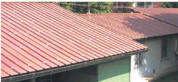
por las placas **COVER-LIFE** demuestran un alto nivel de "Resistencia acústica", según la EN ISO 140/3 y la EN ISO 717/1 (el índice de resistencia al ruido  $R_w$ , obtenido para las placas es igual a 28 dB).
